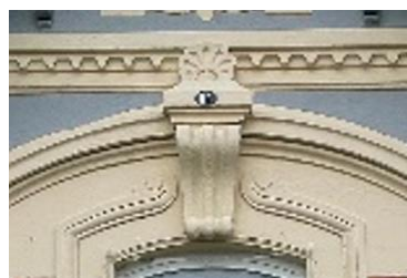
Linteau d'une maison gujanaise
