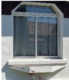
Appuis de fenêtre d'une maison gujanaise
