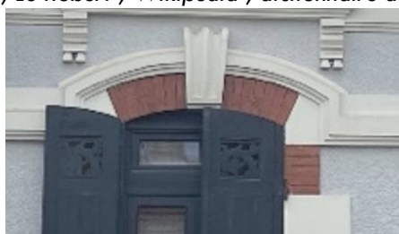
Linteau d'une maison arcachonnaise
